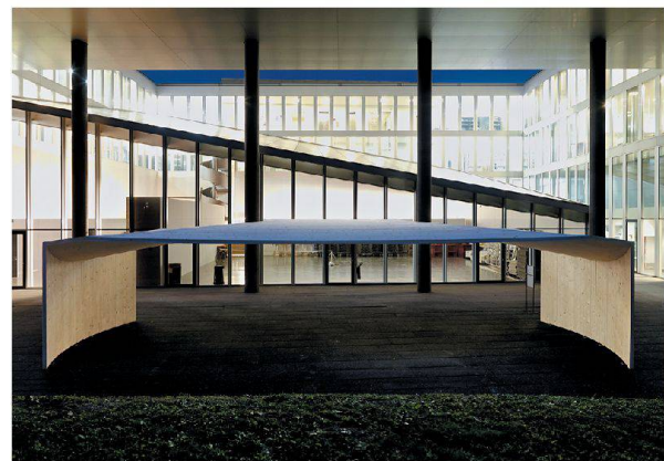
Diese Prinzipien wurden 2013 für das gekrümmte Faltwerk in Mendrisio erweitert.
