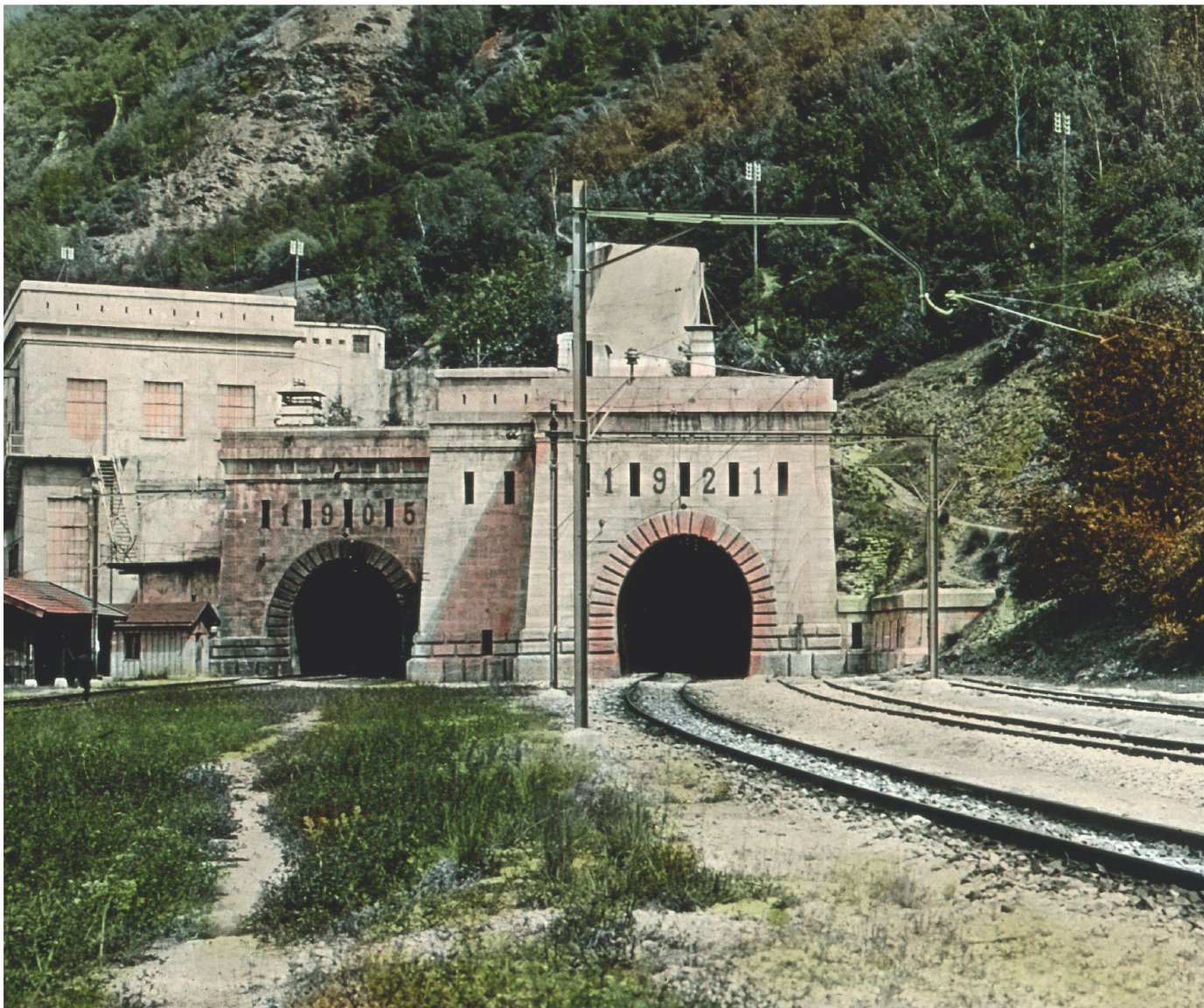
Nordportale des Simplontunnels bei Brig. Im Innern laufen seit 2012 Instandsetzungsarbeiten.
