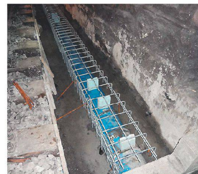
Einbau eines rostfreien Korbs aus Bewehrungsstahl vor der Füllung mit Schotter.
