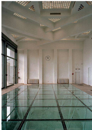
Das ehemalige Hallenbad wurde mit einem Glasboden versehen und wird heute als Ausstellungsraum genutzt.
