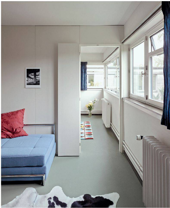
Dank der neuen Falttür an der Fassade ist das Bandfenster im Obergeschoss in seiner ganzen Länge zu sehen.
