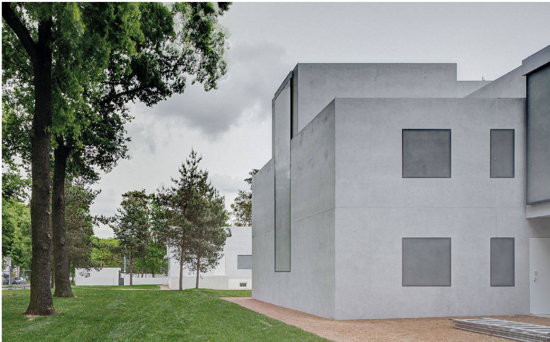
Der Neubau Moholy-Nagy ergänzt das Meisterhaus Feininger.
