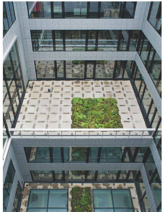
Die fünf neuen Höfe sorgen für ausreichende Belichtung der Innenräume der Hochschule.
