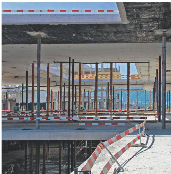
Die Toni-Molkerei wurde 2011 bis auf ihren Rohbau rückgebaut, dieser wurde dann stark angepasst. Die Voraussetzungen dafür waren von Beginn an eingeplant worden.
