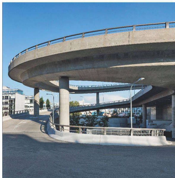
Die Rampe dient als Aufenthaltszone und Zugang für die Besucher der Konzertsäle und des Kinos. Als Fluchtweg darf sie wegen der zu grossen Steigung nicht dienen.
