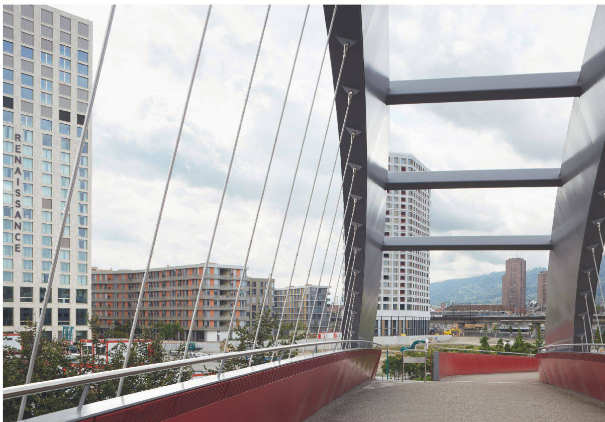
Der Gleisbogen erstreckt sich als rotes Band entlang des ehemaligen Industriegleises durch Zürich-West und erschliesst dem Langsamverkehr den Weg über die Pfingstweidstrasse zum Bahnhof Hardbrücke. Bauten von links nach rechts: Mobimo Tower, Wohnhäuser Am Pfingstweidpark und Wohnhochhaus Zölly. Rechts im Hintergrund die städtischen Hardau-Hochhäuser.
