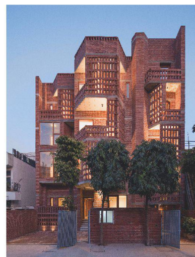
Die stimmungsvolle Fassade des Wohnhauses in Neu-Delhi ist das Resultat unterschiedlicher gemauerter Steine.
