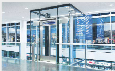
Die durchsichtigen Personenaufzüge sorgen im Bahnhof Aarau für den Durchblick.
