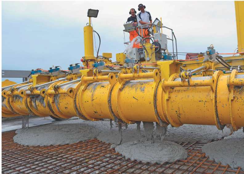
Mittels einer Verteilschnecke der Einbaumaschine wurde der Frisch-UHFB je nach Etappe auf 120 bis 600 cm Breite versetzt (oben links). Eine Art Schaber verteilt den Frisch-UHFB , der mit leistungsstarken Vibratoren fertig eingebaut wird (oben rechts).
