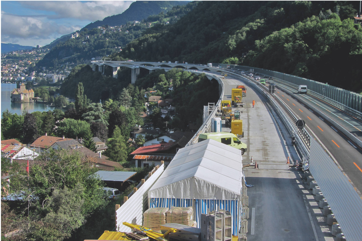
Instandsetzung des ersten Viadukts auf der A9 (mit dem Schloss Chillon links im Bild). Das zweite Viadukt war vierspurig befahrbar.
