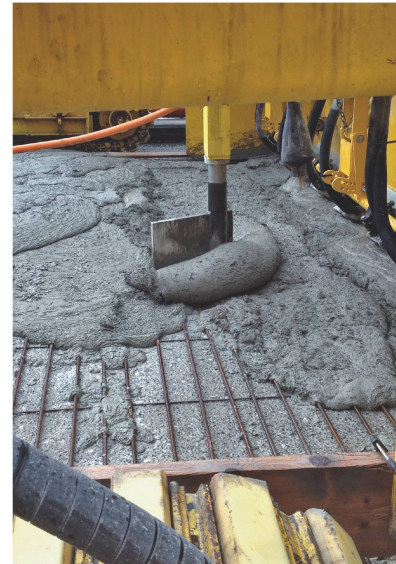
Mittels einer Verteilschnecke der Einbaumaschine wurde der Frisch-UHFB je nach Etappe auf 120 bis 600 cm Breite versetzt (oben links). Eine Art Schaber verteilt den Frisch-UHFB , der mit leistungsstarken Vibratoren fertig eingebaut wird (oben rechts).
