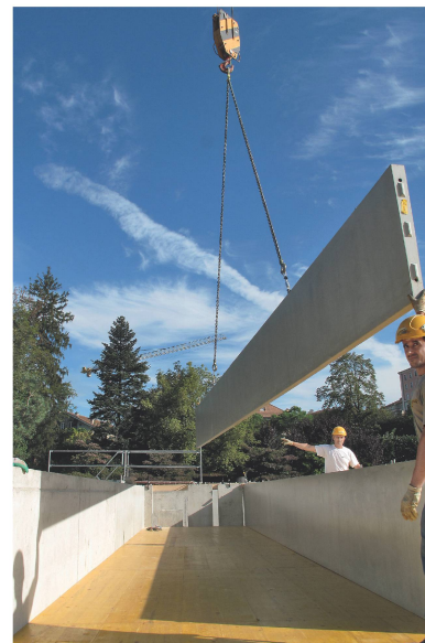
Links: Versetzen der Längsrippen auf der Baustelle. Rechts: Die Nocken auf der Stirnseite der Rippen vereinfachen die Fügung.
