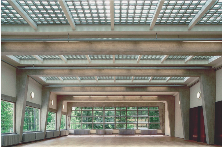
Für die Renovation der ehemaligen Bundesschule des Allgemeinen Deutschen Gewerkschaftsbunds von Meyer-Wittwer erhielten Brenne Architekten mehrere Preise.
