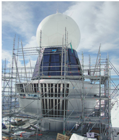
Die Unterkonstruktionsprofile mussten wegen des hohen lokalen Windsogs dicht platziert werden.
