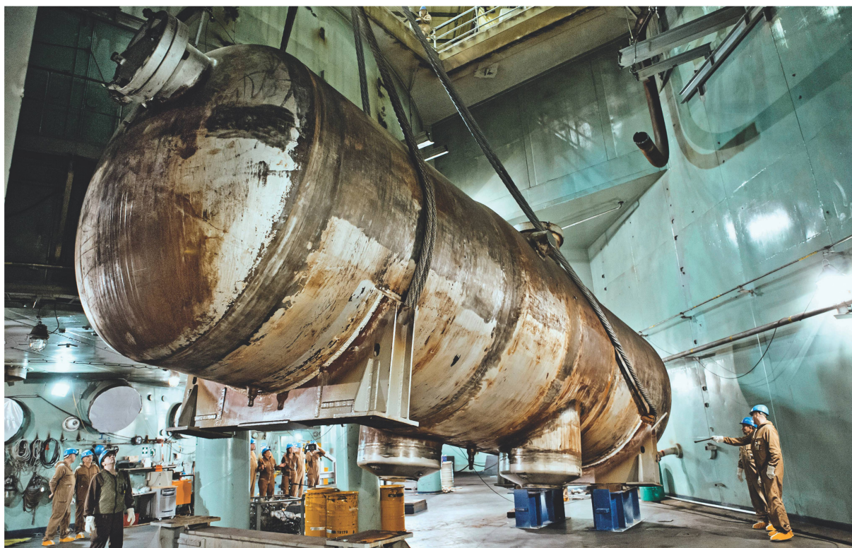
KKW Lubmin bei Greifswald: Dampferzeuger und Reaktordruckgefässe sind an Trocken- und Nasszerlegeplätze gebracht worden.
