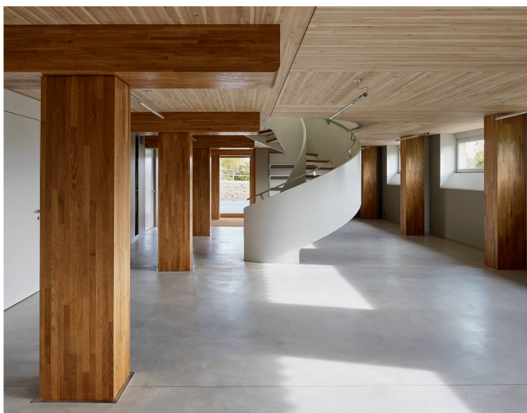
«Sprechendes» Tragwerk im BBZ Arenenberg: mächtige Sattel und gerichtete Decken.
