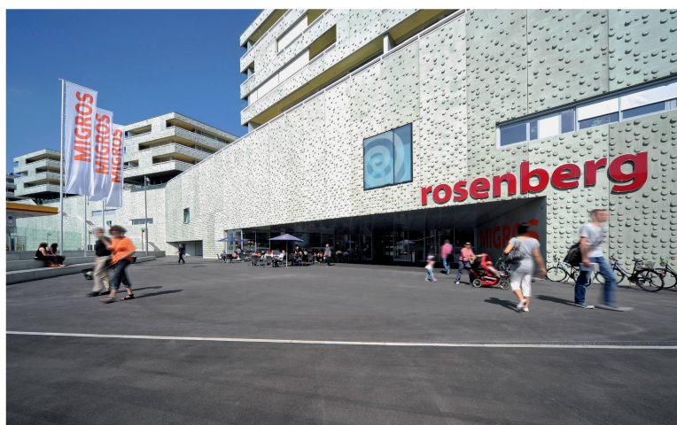
Der Wohn- und Einkaufskomplex Rosenberg in Winterthur ist mit einem SNBS-Pilotzertifikat ausgezeichnet worden (Architektur: atelier ww).
