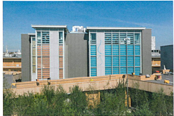
Der Schweizer Expo-Länderpavillon in Mailand: Die Verhandlungen zur Weiterverwendung der Bauteile sind noch im Gang.
