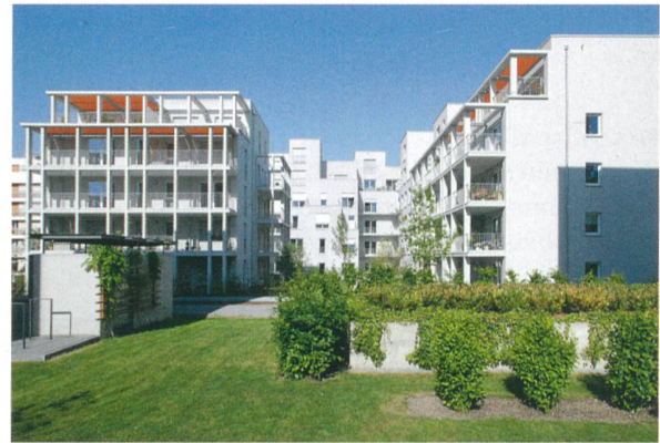
Über dem Boden wurde nur Recyclingbeton verwendet; darunter wäre mehr möglich gewesen.
