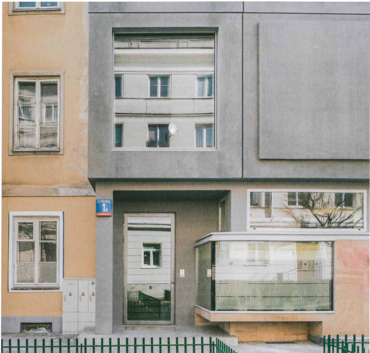
Nordseite: Das Erdgeschoss blieb unverändert, die Obergeschosse erhielten eine Fassade aus vorfabrizierten Betonelementen.
