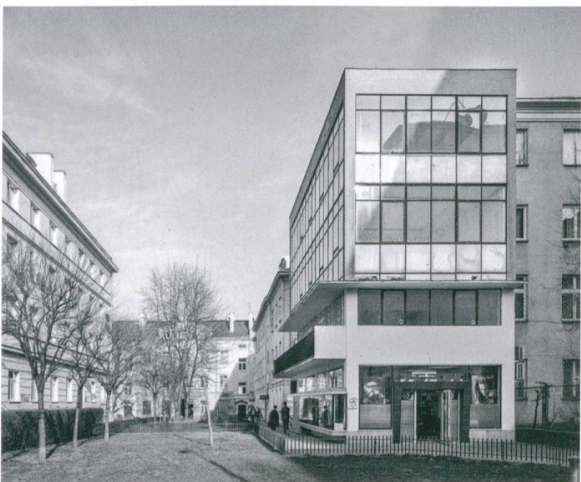
Ansicht vor dem Umbau: Die feingliedrige Stahl-Glas-Fassade war nicht mehr zu retten.
