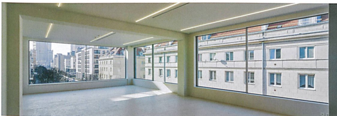
Ausstellungsebene im 3.OG: Die Betontragstruktur blieb erhalten und trägt die neue Fassade; die Heizung ist im neuen Anhydritboden integriert. Durch die grossen Fenster auf der Ost- und Südseite schweift der Blick in die ulica Górskiego mit ihrer neotraditionalistischen Architektur der 1940er- und 1950er-Jahre.
