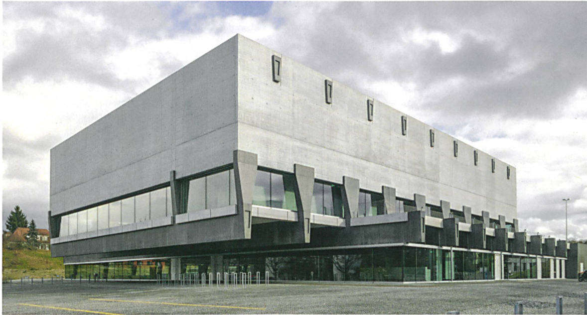
Sporthalle Weissenstein: Die statischen Elemente des Sichtbetonbaus wurden mit einer Lasur aus Grafit hervorgehoben.
