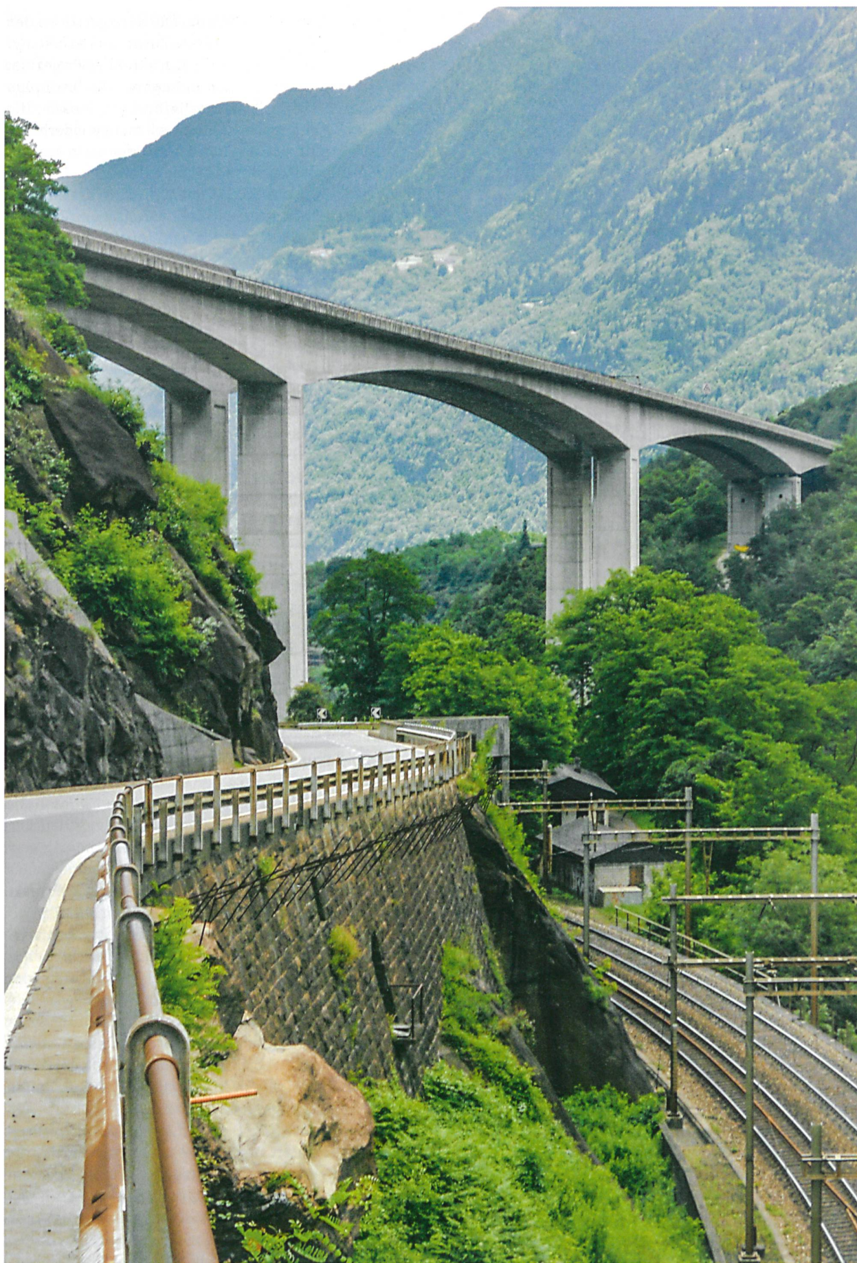
Verkehrslandschaft Leventina: Kantonsstrasse, Autobahn und Eisenbahn zwängen sich durch die Biaschina zwischen Lavorgo und Giornico. Der elegante Biaschina-Viadukt ist mit 110 m über Talgrund eines der höchsten Brückenbauwerke der Schweiz.
