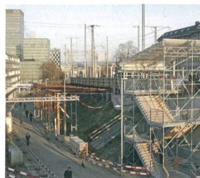
Hilfsbrücken am Bahnhof Oerlikon.
