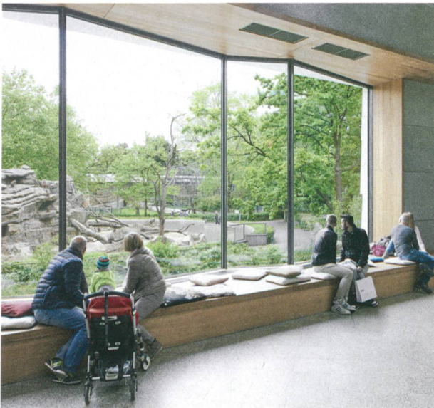
Die Nordfassade öffnet sich mit einem 4×14 m grossen Fenster zum benachbarten Zoo mit Blick auf das Paviangehege.
