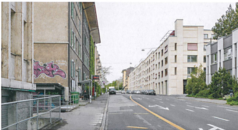
Die Wohnüberbauung Brunnmatt-Ost im Berner Mattenhofquartier: fein modulierte Backsteintektonik an der grossmassstäblichen Siedlung.
