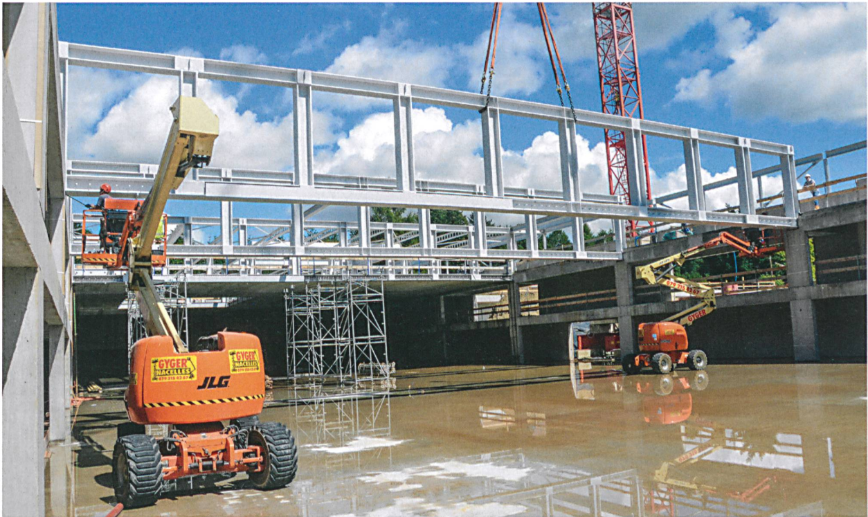
Montage der 30 t schweren Vierendeelträger. In der Trägerhöhe über der Schiesshalle werden diverse Nutzungen in einem 10.80×3.06 m Raster, ohne tragende Wände oder Fachwerkdigonalen, untergebracht.
