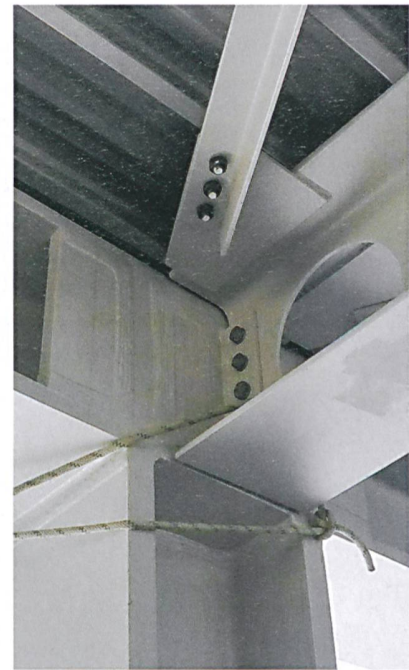
Links: Erdgeschossaufbau. Rechts: biegesteife Ausbildung der Knoten des Vierendeelträgers. Die umfangreichen Schweissarbeiten im Werk betragen etwa 750 Stunden pro Träger.
