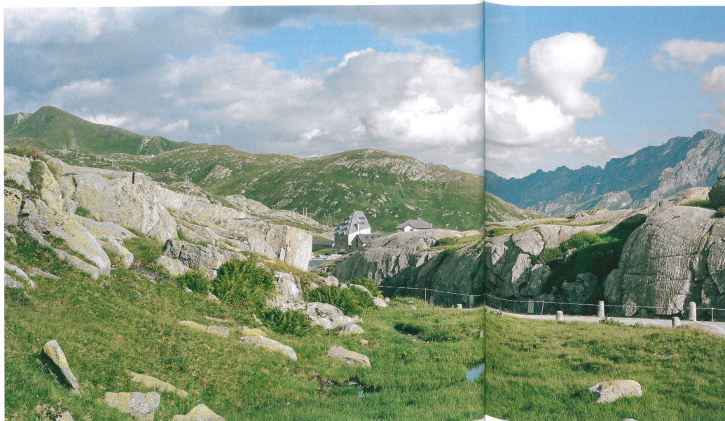
Umbau und Aufstockung des alten Hospizes St. Gotthard, 2010, Miller & Maranta Architekten.
