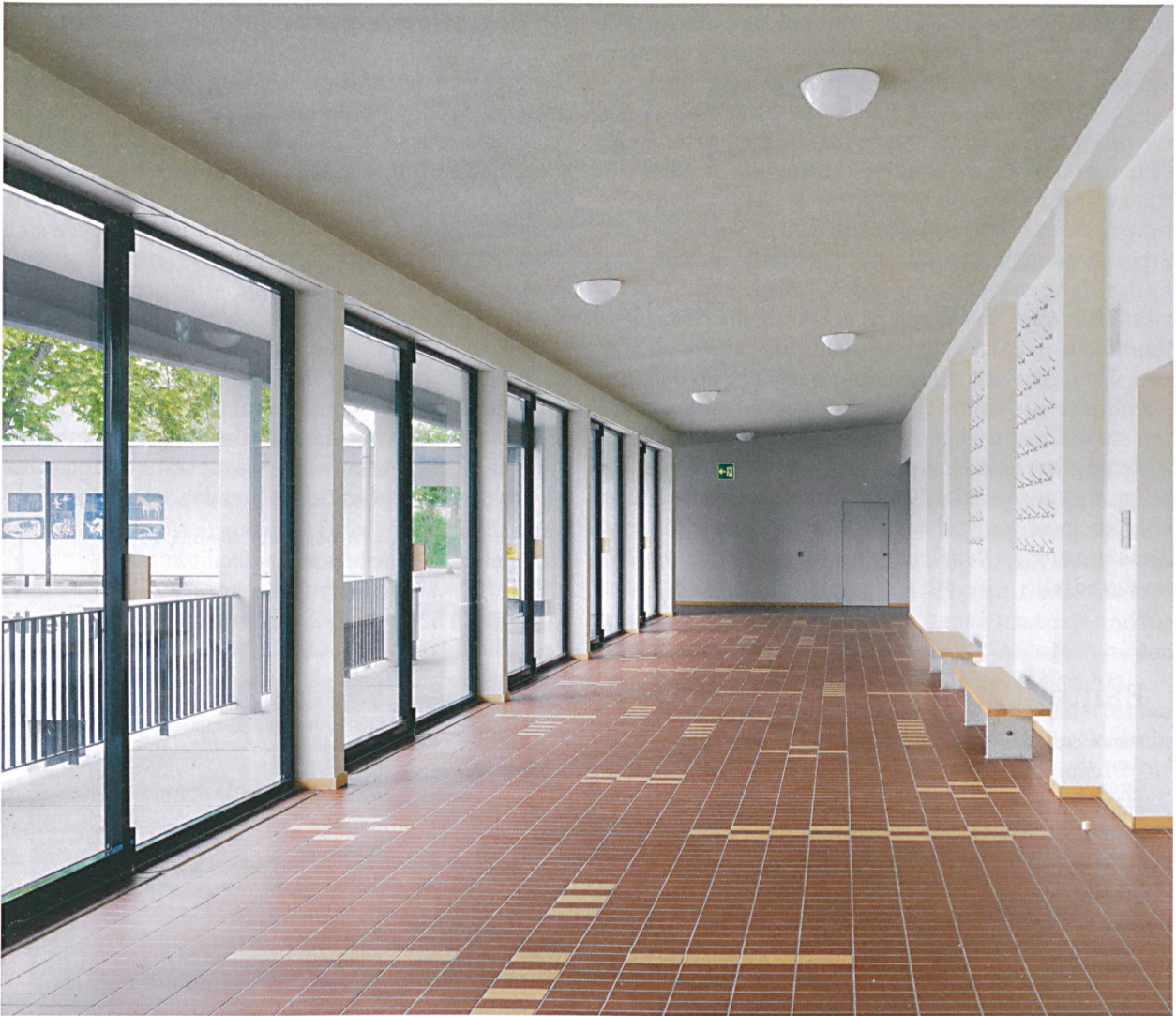
Das der Aula vorgelagerte Foyer: Die ehemals geschlossene Fassade wurden mit Glasschiebefenstern versehen. Wo früher die Umkleidekabinen untergebracht waren, öffnet sich der Bau nun zur Terrasse des Hauptzugangs. Es entsteht eine Blickachse zwischen Aula und Schulhaus, die räumliche Verbindung zwischen den Trakten wird gestärkt.
