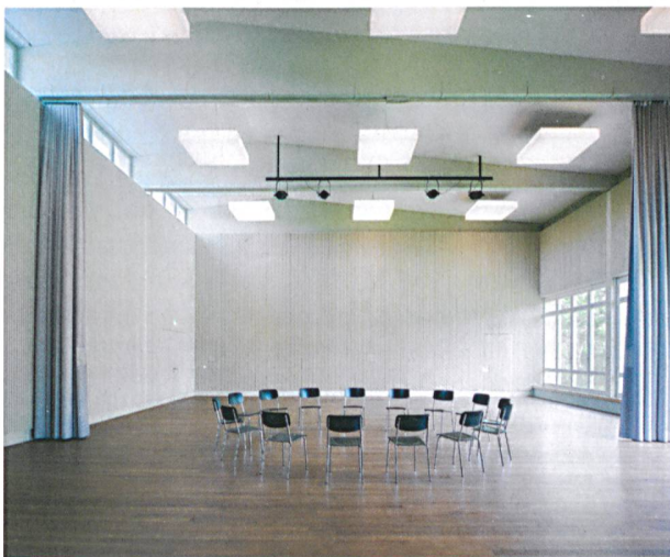
Von Turnhalle zu Aula: Holzlamellen an den Wänden verbessern die Akustik, raumhohe Vorhänge in der Mitte erlauben eine Zonierung. Die Dachträger sind von der Aussenfassade zum Foyer trapezförmig von 0.45 \times 1.35 m in der Höhe zunehmend.
