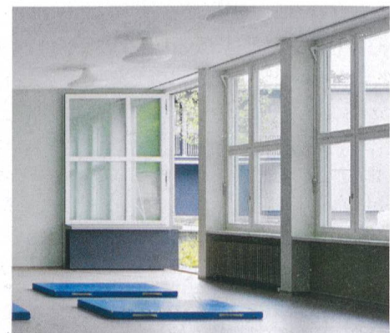
Fassadentor im UG
