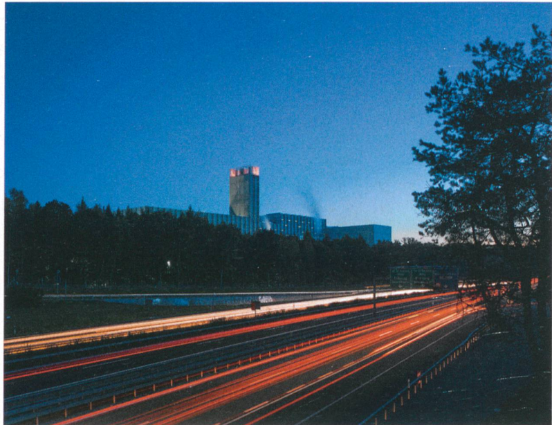
Saubere Energie: die Kehrlichtverwertungsanlage Bern Forsthaus von Graber Pulver Architekten, gleich neben der Autobahn gelegen.
