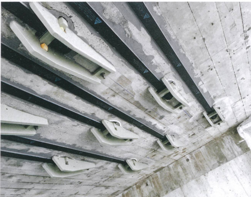
Links: Untersicht der CFK-Lamellen. Rechts: Grundriss der Spannsystems.
