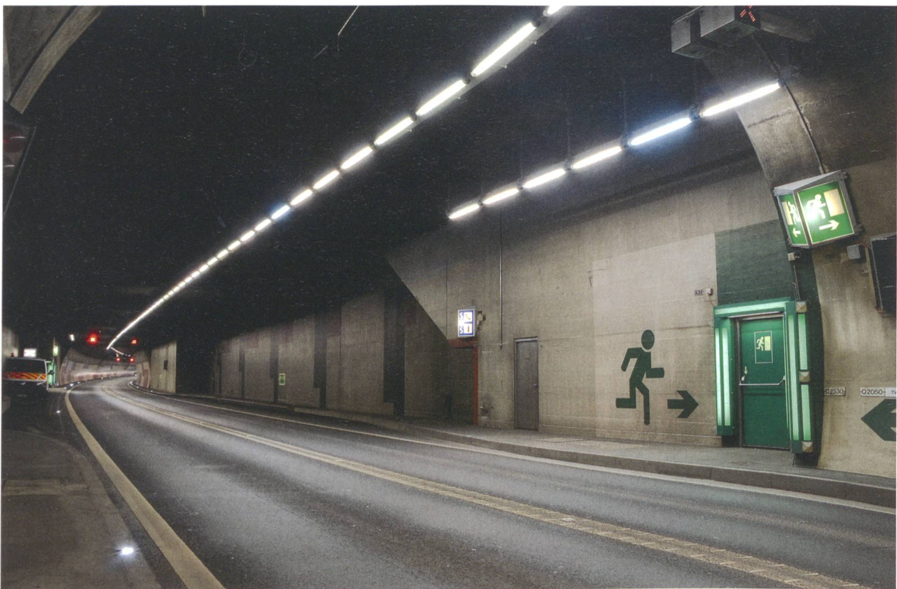
Autobahn A4 (Winterthur–Schaffhausen): Der Fäsenstaubtunnel unterquert die Stadt Schaffhausen.
