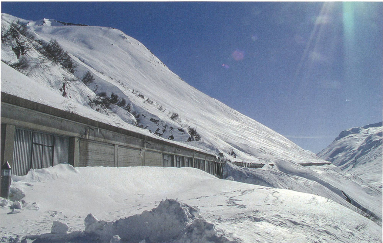
Lawinengalerie Scopi im Winter. Die Lukmanierstrasse wird nördlich der Passhöhe durch viele Lawinenzüge gefährdet. Zum Schutz des Verkehrs wurde in den 1960er-Jahren die etwa 2 km lange Lawinengalerie Scopi gebaut. Im Winter ist die Galerie zum Teil beinahe vollständig mit Schnee von Lawinenniedergängen eingedeckt.
