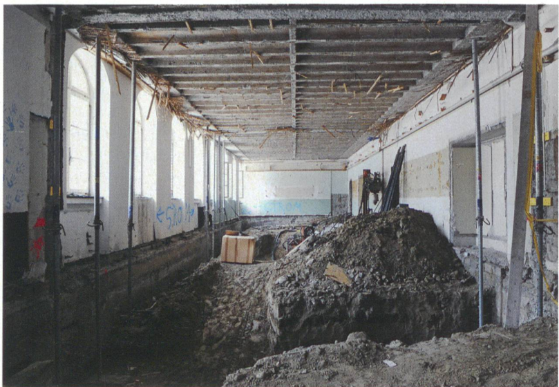
Ausgezeichnet für eine denkmalgerechte Ertüchtigung: Preisträger Renovation Oberstufenschulhaus Quader, Chur.
