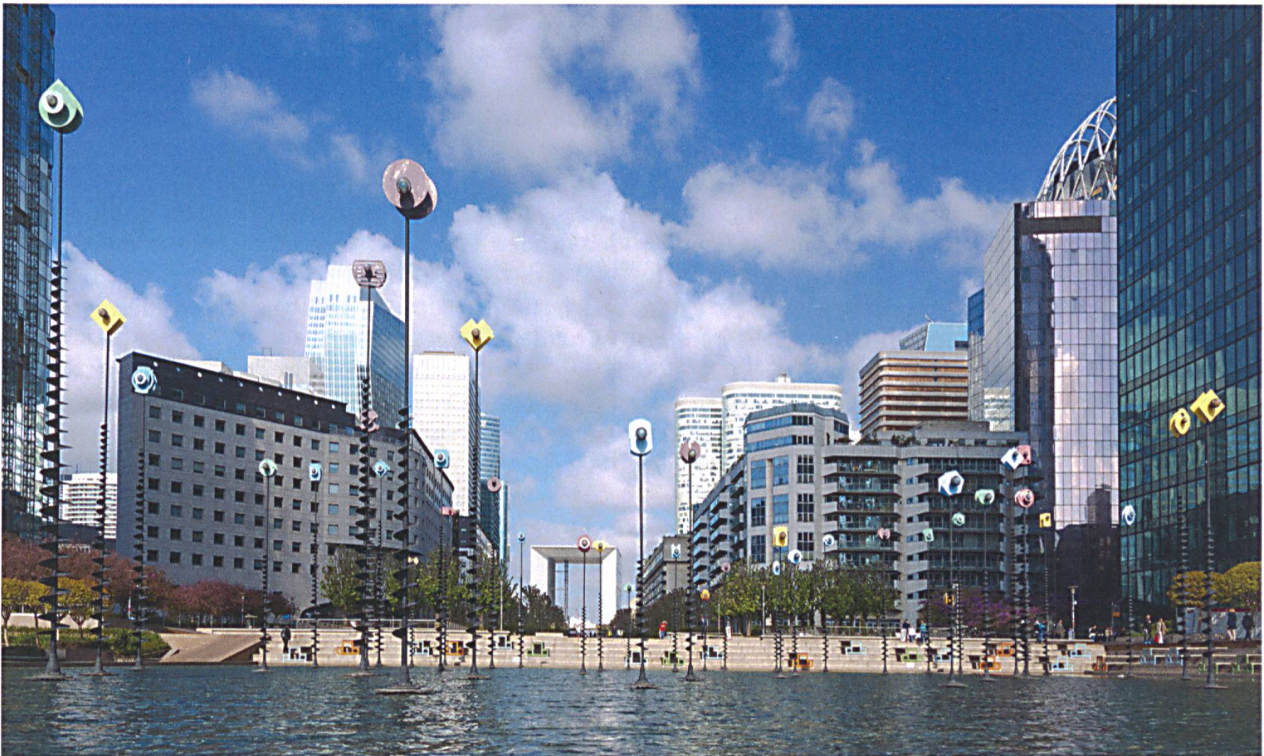
Im Hochhausquartier «La Défense» in Paris werden Eisspeicher aus der Schweiz eingesetzt. Dank den Speichern mit einer Kapazität von über 100 MWh arbeitet das Kühlsystem effizienter und kostengünstiger.
