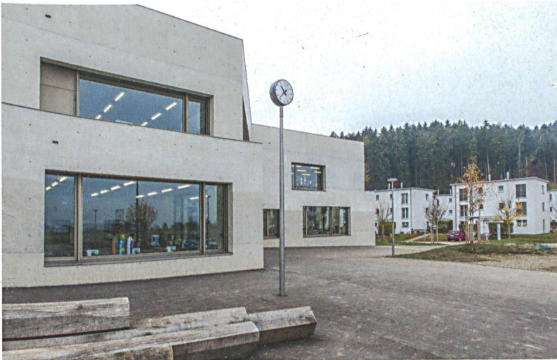
Das Schulhaus in einer Vorortgemeinde von Winterthur erforscht einen neuen Typus: Rund um die Turnhalle sind die Zimmer angeordnet. Für diesen eigenständigen Entwurf gibt es den Hasen in Silber für Adrian Streich Architekten.
