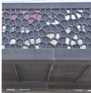
Links: Die Negativform des «organischen» Musters wurde mit einer PVC-Matrix realisiert. Rechts: «organischer» Steg und Fuge zwischen zwei Fertigteilen.
