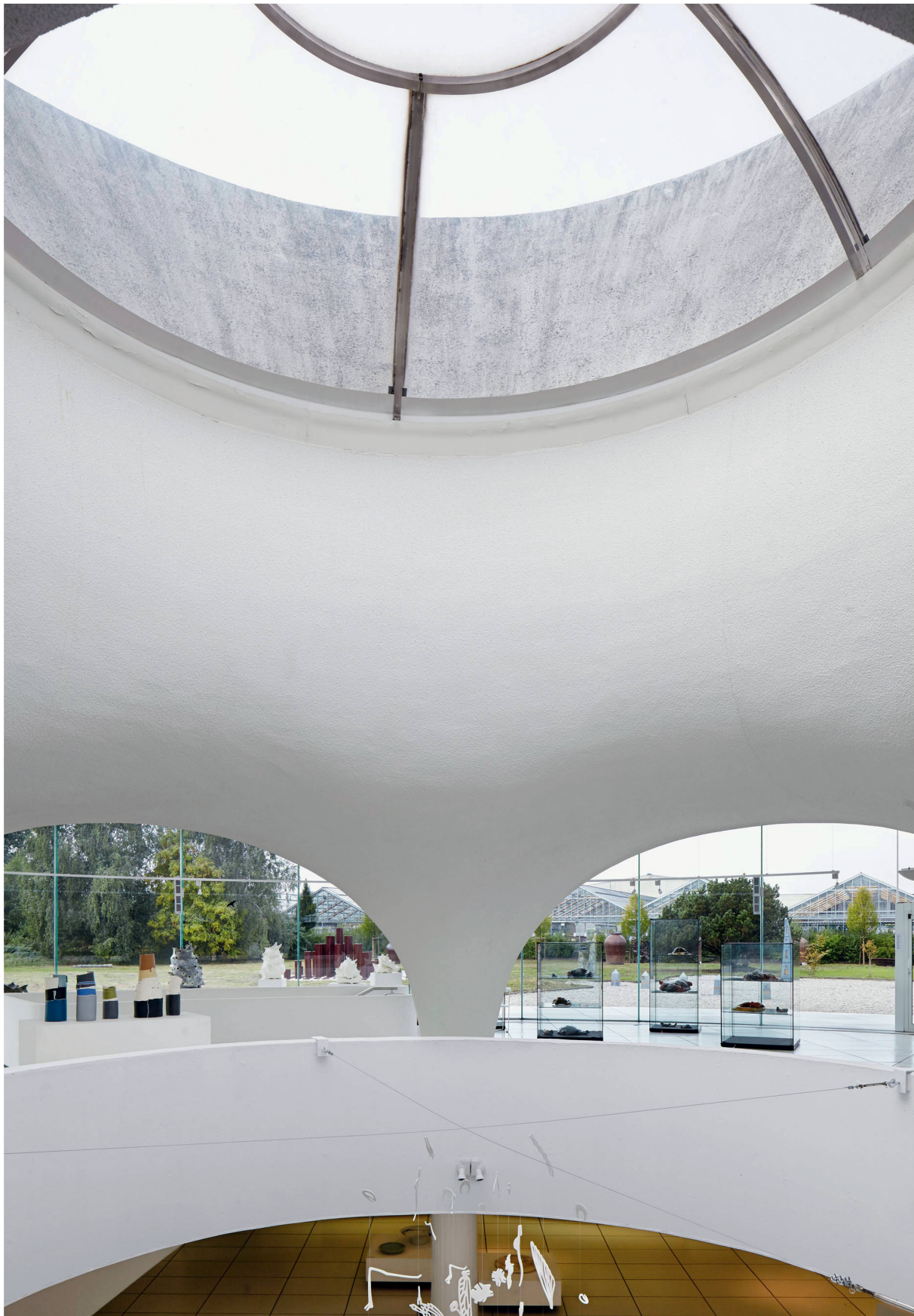
Aus der Dachschale des Museums stülpt sich ein Hyperboloid nach oben. Durch seinen auskragenden Aufsatz fällt Tageslicht über einen Hof bis in die untersten Räume.
