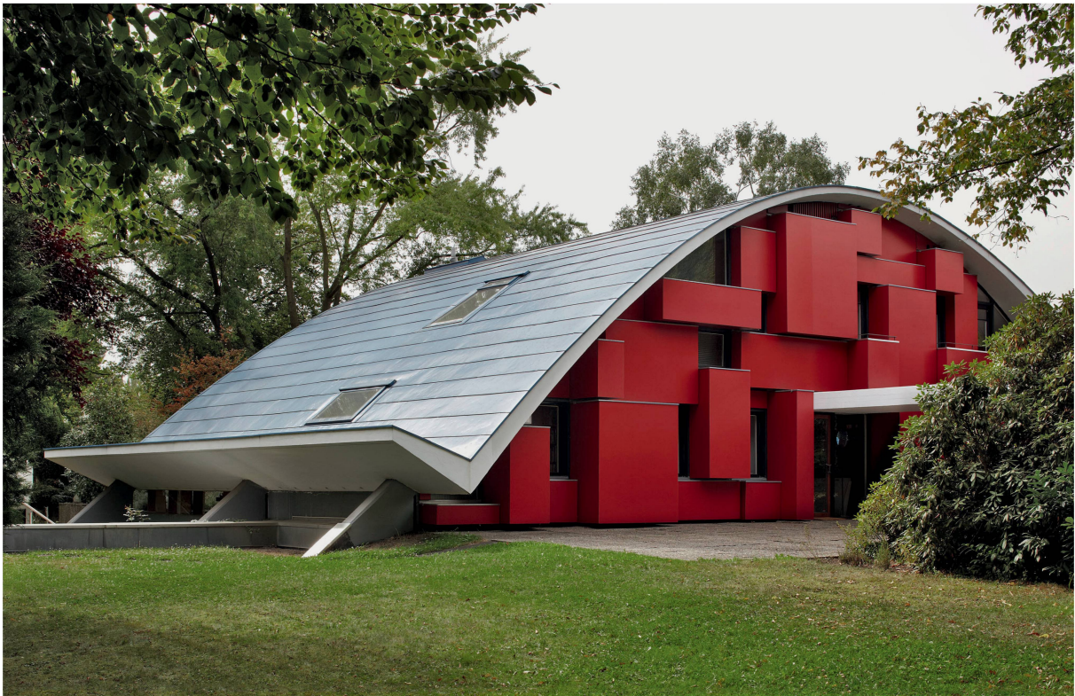
Die Eingangsfassade des Hauses X1 in Köln-Hahnwald ist durch verschiedene Kästen gegliedert, hinter denen sich Schränke, Balkone oder Heizkörper verbergen. Die Krümmung der Dachform folgt einer Klothoide.
