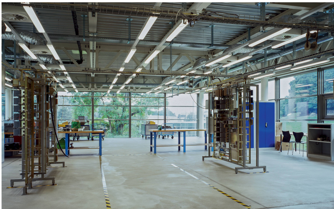
Bei der Werkstatt und den Verwaltungsräumen konnte der Stahlbau sichtbar gelassen werden, im Gegensatz zum Treppenhaus, das als separater Brandabschnitt ausgewiesen werden musste.
