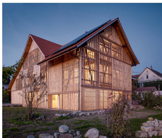
Die Scheune steht im Weiler Dingenhart bei Frauenfeld. In der ländlich geprägten Umgebung stellen die offenen Grundrisse ein Experiment dar. Situationsplan im Mst. 1:5000.
