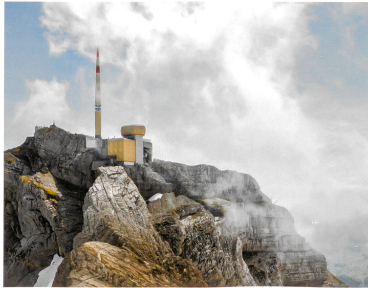
Bergstation der Säntisbahn, Schwägalp AR, errichtet 1968–1974 von Esther und Rudolf Guyer.
