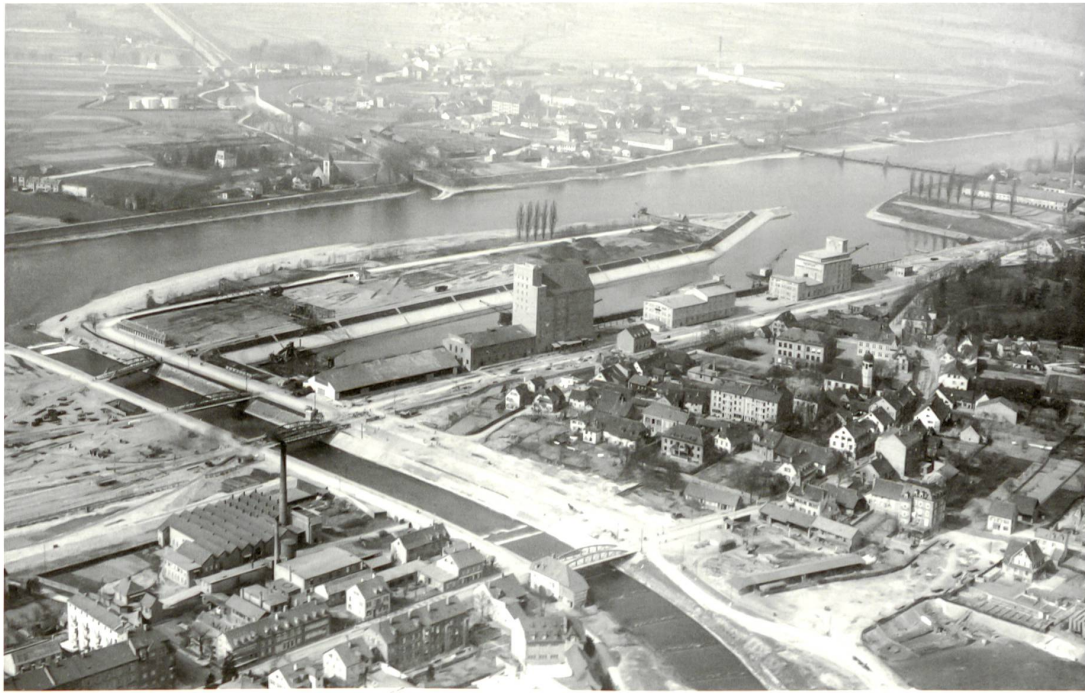
Die Luftaufnahme vom März 1926 zeigt das noch intakte Dorf Kleinhüningen. Entlang des Flüsschens Wiese sind die Arbeiten für die Neuanlage der Hochbergerstrasse im Gang, am Hafenbecken I stehen die ersten Silo- und Lagerhausbauten. Der Westquai verfügt rheinseitig noch über die charakteristischen Sandbänke.
