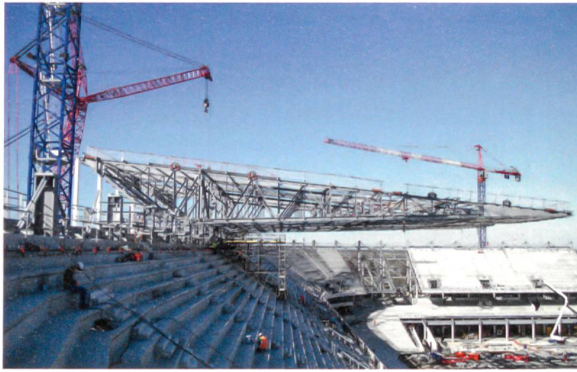
Blick auf ein Element der Stahlkonstruktion für das auskragende Stadionsdach. Das Dach hat ein Gefälle von 7°.
