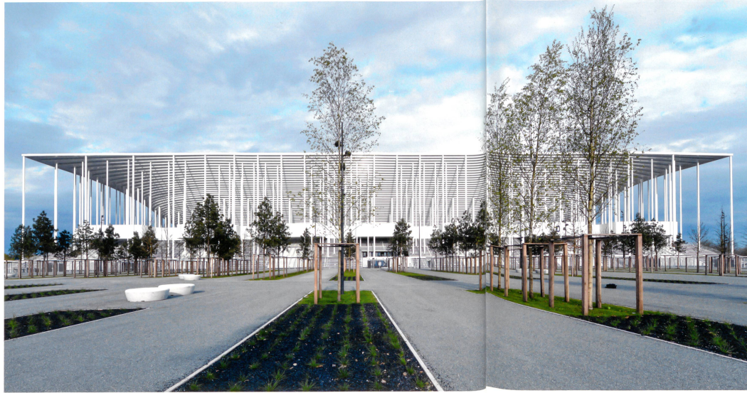
Links: Das neue Stadion in Bordeaux vereint mithilfe seiner Konstruktion die Kontraste von Schwere und Leichtigkeit und schafft fließende Übergänge zwischen Aussen- und Innenraum. Ganz oben: freie Sicht aufs Spielfeld dank auskragender Stahlkonstruktion. Darunter: der Säulenumgang im Empfangsbereich als räumlicher Vermittler.
