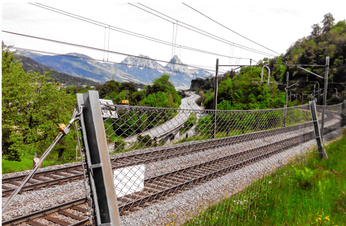
Abschnitt der Gotthardstrecke am Fuss der Rigi bei Arth SZ: Die Naturgefahrenalarmanlage registriert Erschütterungen im Netz und übermittelt die Informationen über die gelben Kästchen an die Naturgefahrenfachleute der SBB.
