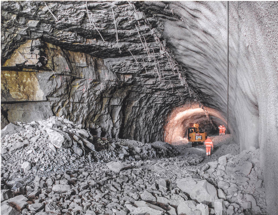
... 1200 m 3 Gesteinsschutt. Nach der Sprengung im Bereich der Weichenanlage.
