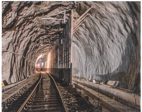
Die Schutzwand nach der Anpassung am Ende der Phase 1. Das talseitige Gleis (rechts) ist noch nicht provisorisch verlegt (Blickrichtung nach Bex).
