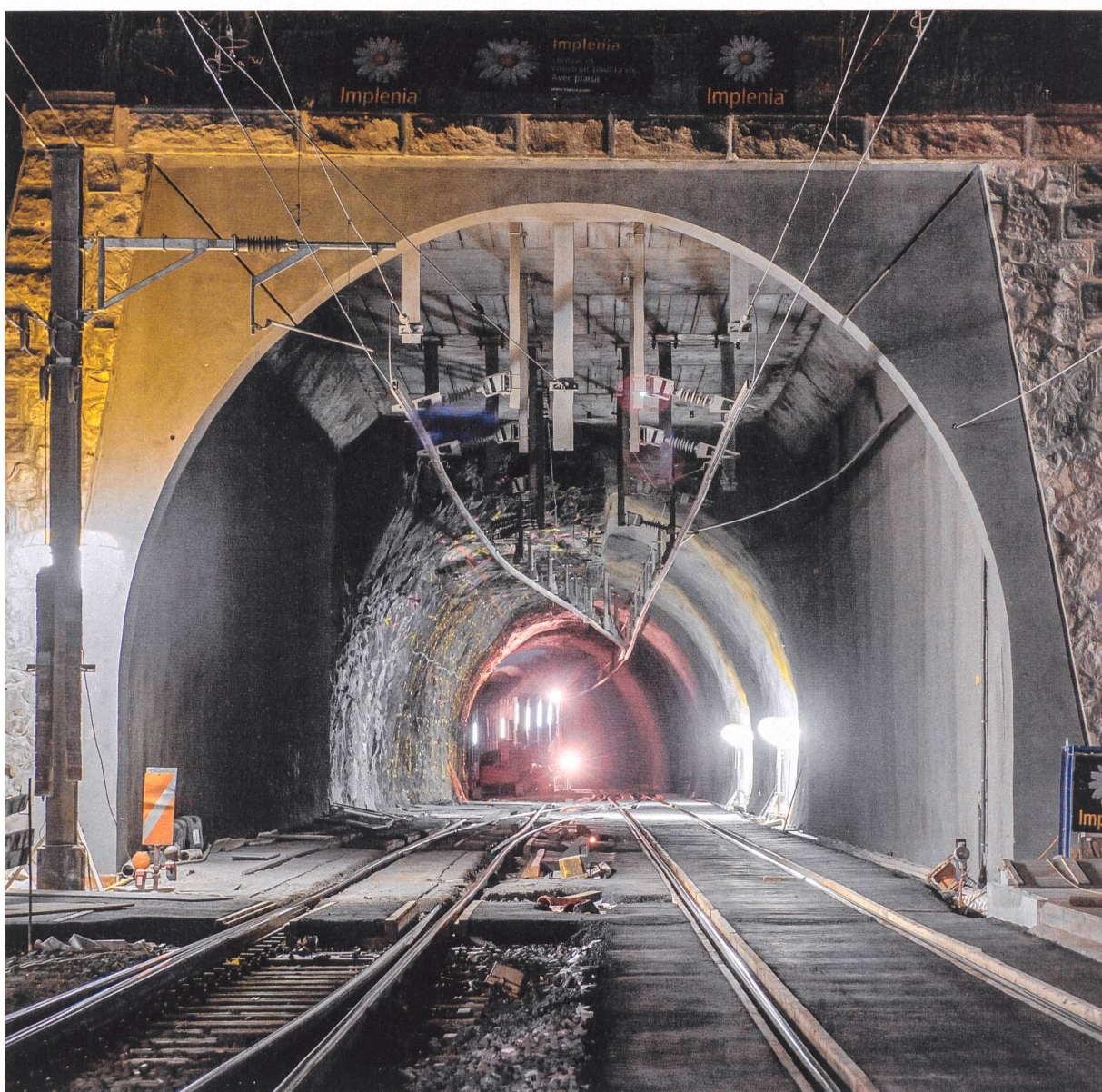
Tunnelportal auf Seite Saint-Maurice vor der Sprengung. In der linken Tunnelhälfte sind die Sprenglöcher ersichtlich. Deutlich auch das Weichensystem innerhalb des Tunnels.
