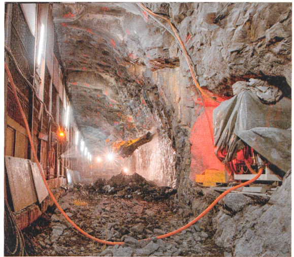
Querschnittsvergrößerung durch Gesteinabtrag mittels Felsbrecher an Kalotte und Strosse am talseitigen Gleis im Bereich Saint-Maurice (Blickrichtung nach Bex); links die Schutzwand.
