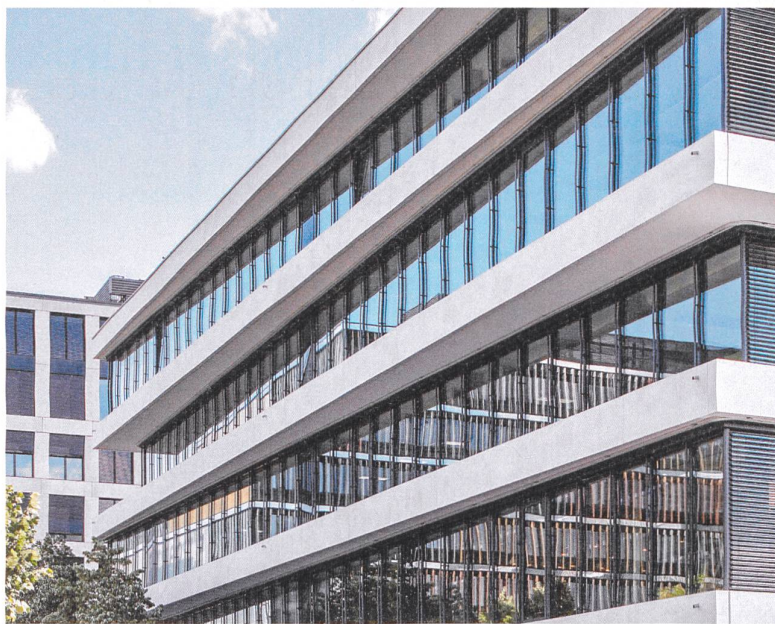
Erster Träger des SNBS-Gebäudezertifikats: der neue Geschäftssitz von Losinger Marazzi an der Wankdorfallée in Bern.
