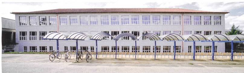
Ostfassade mit der neuen Fensterteilung: Das Oberlicht der aus Unterhaltsgründen mehrheitlich fest verglasten Fenster ist leicht überhöht, wie im Entwurf von Rudolf Christ aus den 1930er-Jahren.
