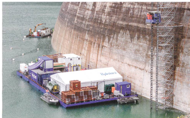
Ponton mit den Einrichtungen für die Unterwasserarbeiten.
