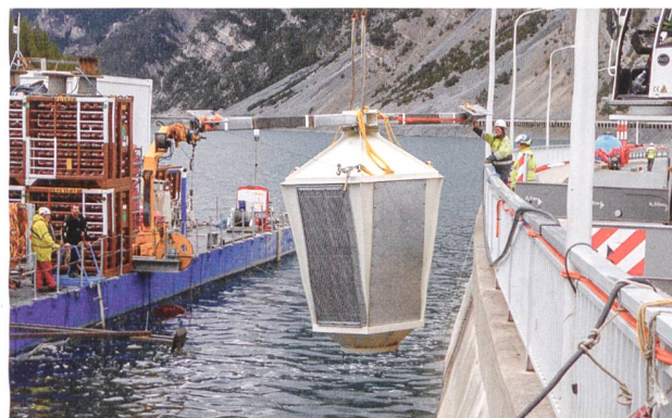
Der Trompeteneinlauf des künftigen Dotierwassereinlaufs wird in den See abgesenkt.
