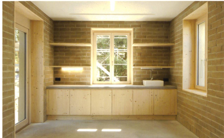
Die Küche des Jardin Botanique-Alpin in Meyrin GE von Véronique Favre Architectes ist mit Lehmbausteinen von terrabloc gemauert.
