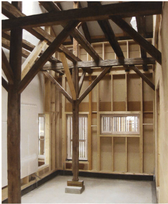
Ein Innenraum der wieder aufgebauten Torfremise in Schechen mit der alten Tragstruktur aus Holz und neuen Wänden.
